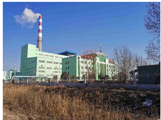
Biomass Power Plants 生物質發電廠
